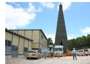
地上からのボーリング調査
