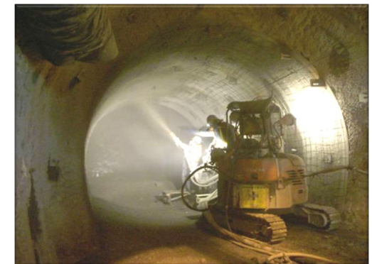
低アルカリ性コンクリート材料を用いた吹付け施工の適用性確認
